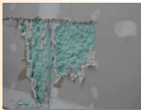
Catas para comprobar el correcto llenado de la cámara. La inyección se puede realizar tanto sobre tabiquería húmeda como seca.
