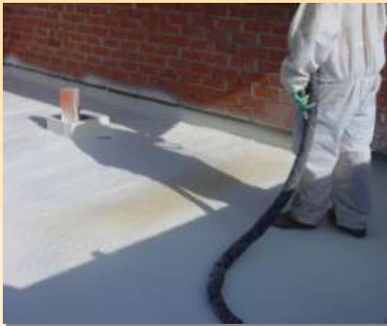
Cubierta transitable proyectada con espuma de poliuretano
