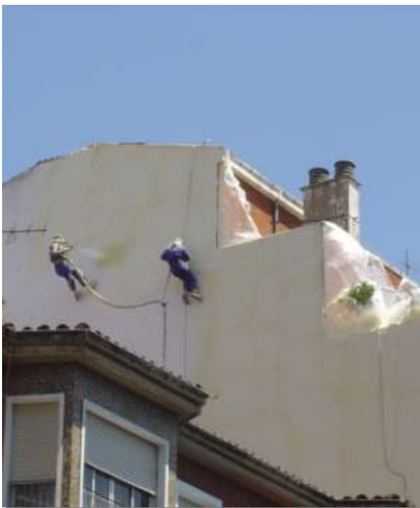
La gran adherencia del poliuretano proyectado hace que no requiera de ningún otro sistema adicional de sujeción.
