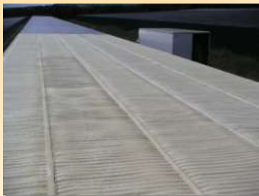
Cubierta de chapa aislada por el exterior, antes de aplicar la protección de la espuma
