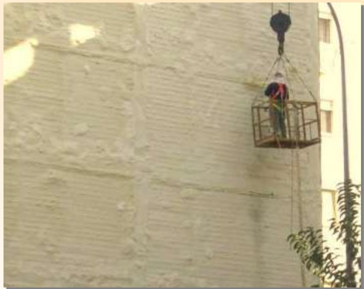
Medianeras aisladas e impermeabilizadas con poliuretano proyectado, antes de recibir la protección UV.
