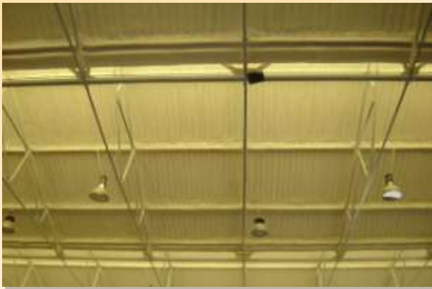
Cubierta de chapa aislada con poliuretano
