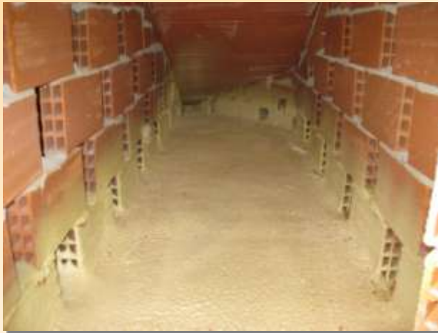
La proyección entre tabiques palomeros se adapta a todos los rincones minimizando los puentes térmicos
