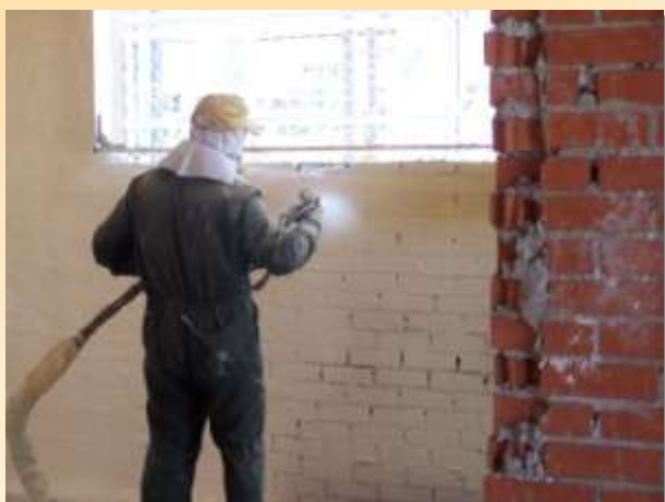
Con producto de celda cerrada, la proyección sobre ladrillo cara vista no requiere de enfoscado previo para garantizar la impermeabilidad
