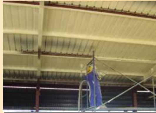
Proyección por el interior antes de la recomendada aplicación de una barrera de vapor.
