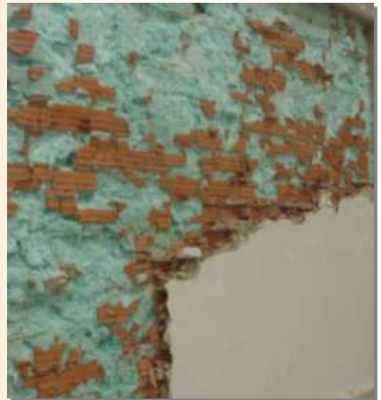
La espuma expande en el interior de la cámara, rellenando el espacio entre las dos hojas
