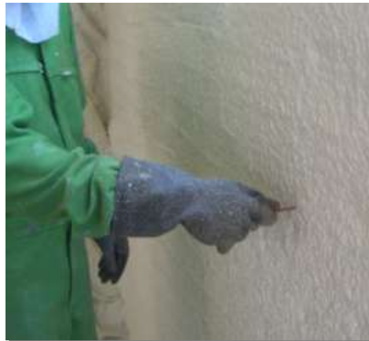
El ensayo de medición del espesor se realizará al menos cada 100 m 2 .
