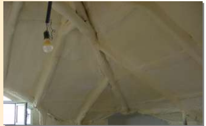
Con el poliuretano proyectado se eliminan fácilmente los puentes térmicos, independientemente de su complejidad
