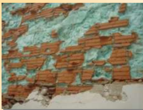
Catas para comprobar el correcto llenado de la cámara. La inyección se puede realizar tanto sobre tabiquería húmeda como seca.
