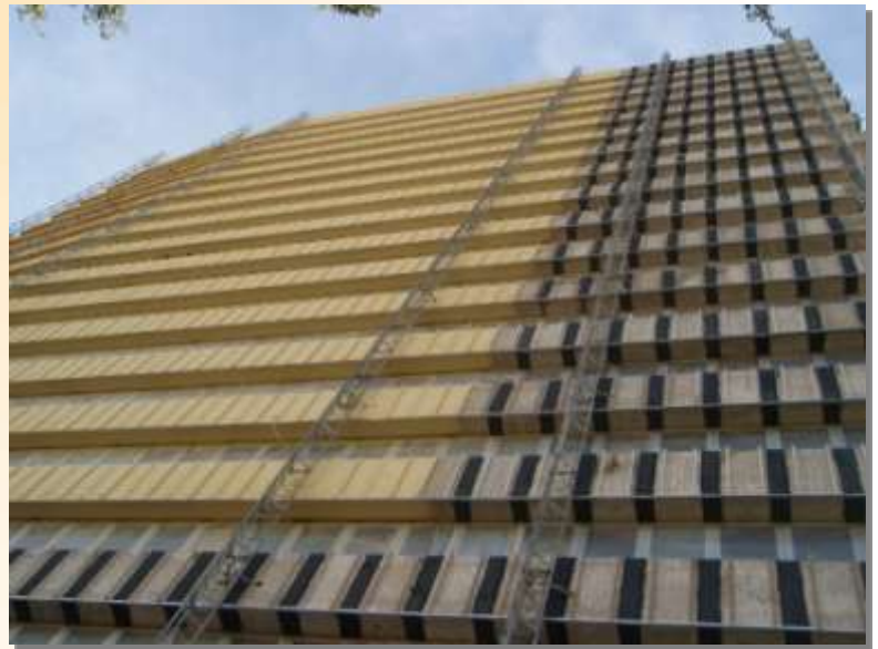
Revestimiento de mortero directo sobre la espuma, previa imprimación y colocación de una malla metálica.
