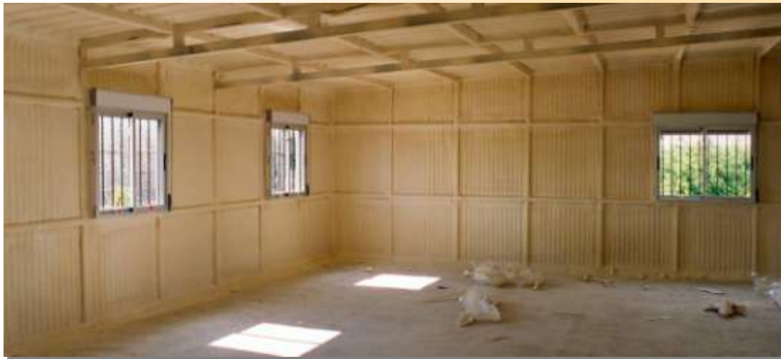
Proyectar poliuretano por el interior es la solución constructiva más apropiada cuando se quiera hacer una rehabilitación integral del edificio.
