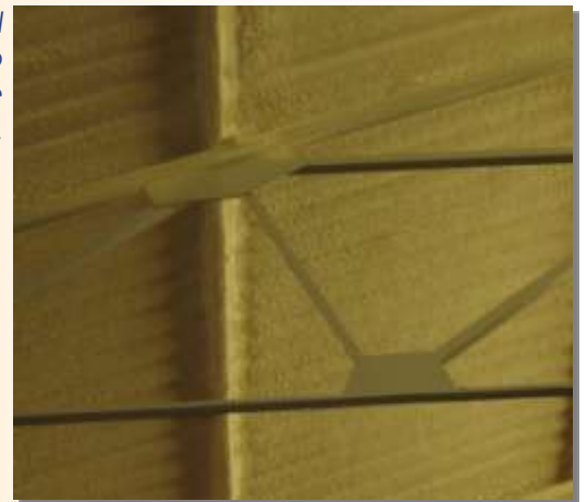
Proyección por el interior, envolviendo la estructura de soporte.
