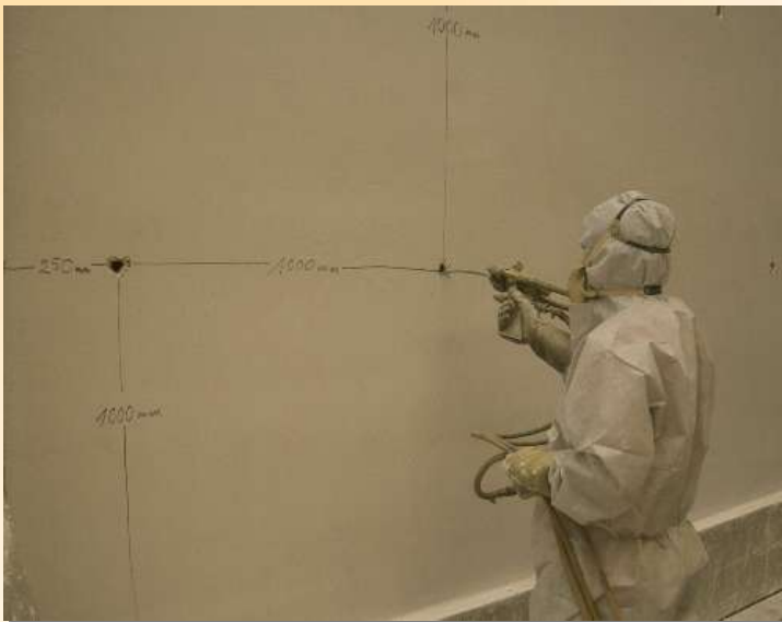
La inyección se realizará a través de orificios practicados en una de las hojas del cerramiento, siempre de abajo a arriba
