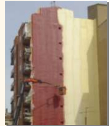
Proyección en medianera con protección
