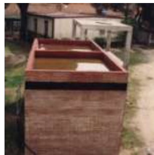
Vista superior de la caseta, con la cubierta inundada e impermeabilizada con poliuretano proyectado.
