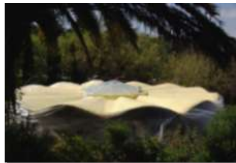
La complejidad de la superficie a aislar no supone ningún inconveniente o retraso.
