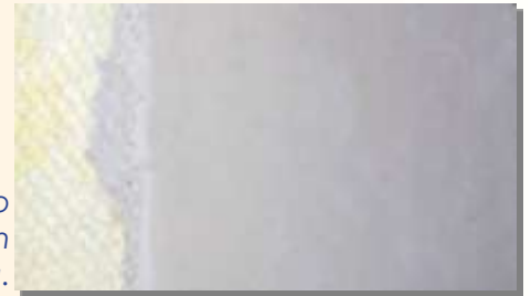
Revestimiento de mortero directo sobre la espuma, previa imprimación y colocación de una malla metálica.
