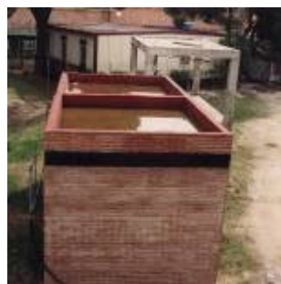
Vista superior de la caseta, con la cubierta inundada e impermeabilizada con poliuretano proyectado.
