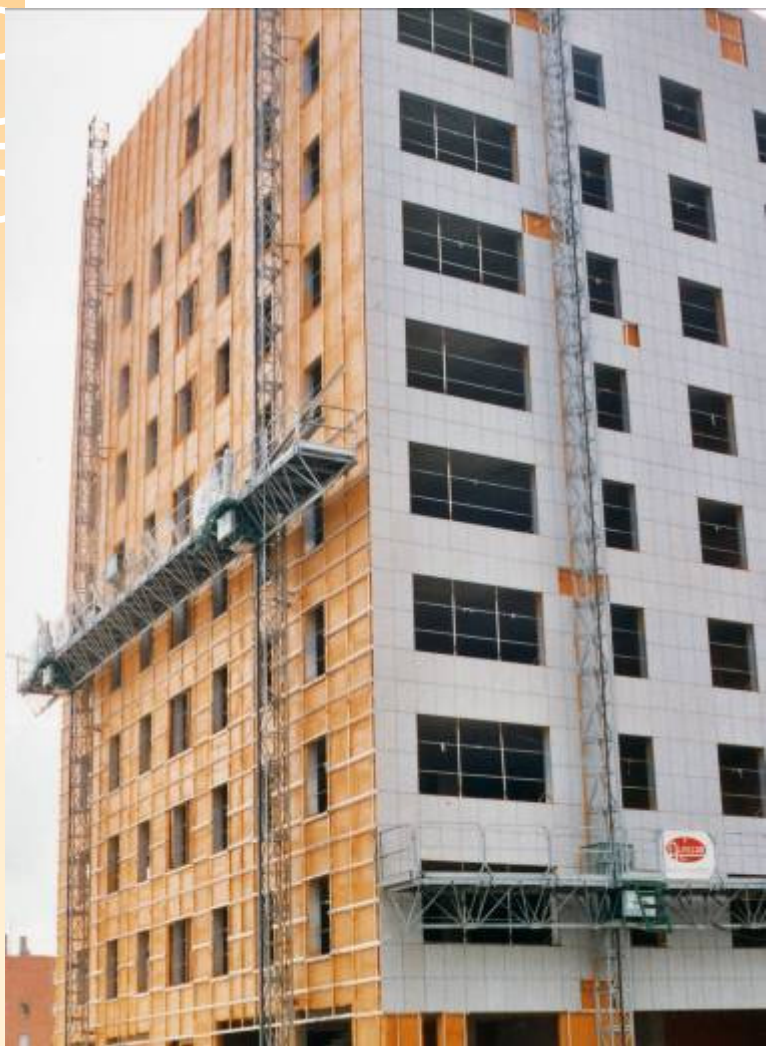
Fachada ventilada proyectada con espuma de poliuretano.
