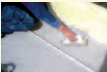
Aplicación de yeso sobre la espuma
